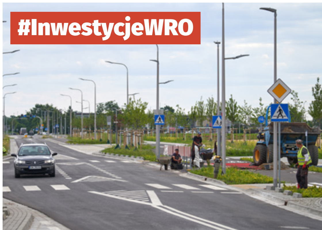
W piątek 14 lipca na budowie prowadzone były jeszcze ostatnie prace wykończeniowe i porządkowe
